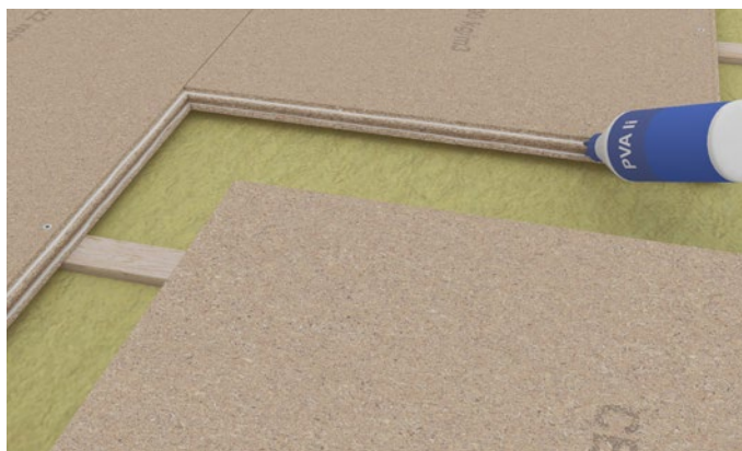
Figur 5 Før samling af pladerne påføres rigeligt lim på begge oversider af feren. Lim der presses op fjernes. Limning til fugtige strøer, se side 4.
