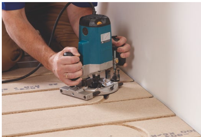
Figur 7 Fræsning af vendespor i hver 2. række.
