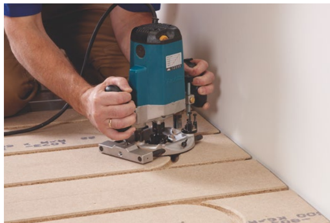
Figur 7 Fræsning af vendespor i hver 2. række.
