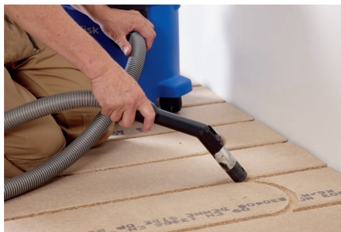
Figur 8 Omhyggelig rengøring forhindrer knirkelyde.
