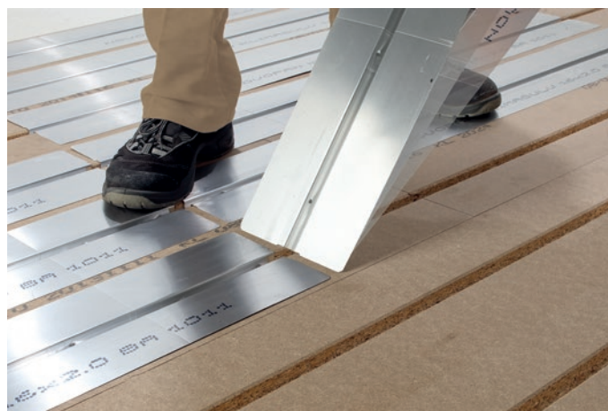
Figur 9 Varmefordelingsplader kan lægges stående.
