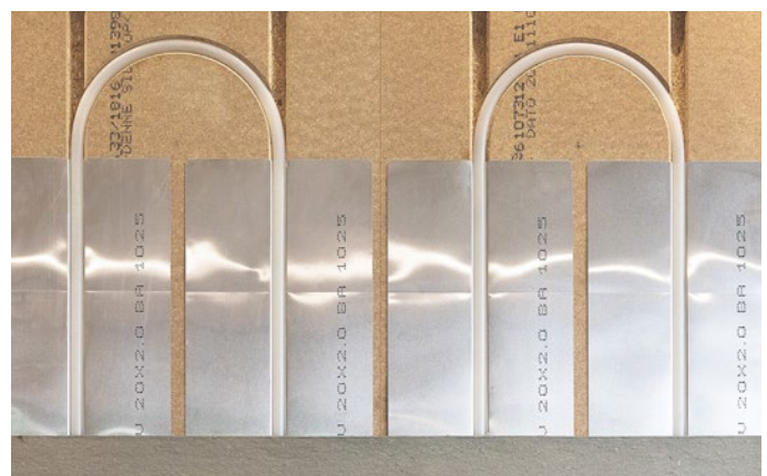
Figur 3 Varmefordelingsplader til 16 mm varmeslanger, sporafstand 200 mm cc.
